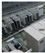
ビルや工場の屋上
